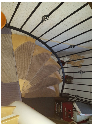
Wendeltreppe zum OG
